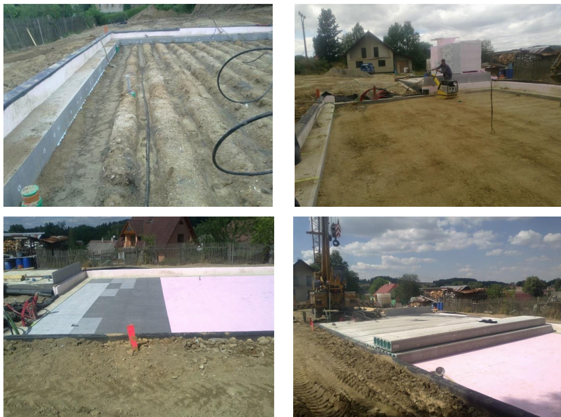
Obr. 3 Výstavba zemního výměníku v podzákladí
