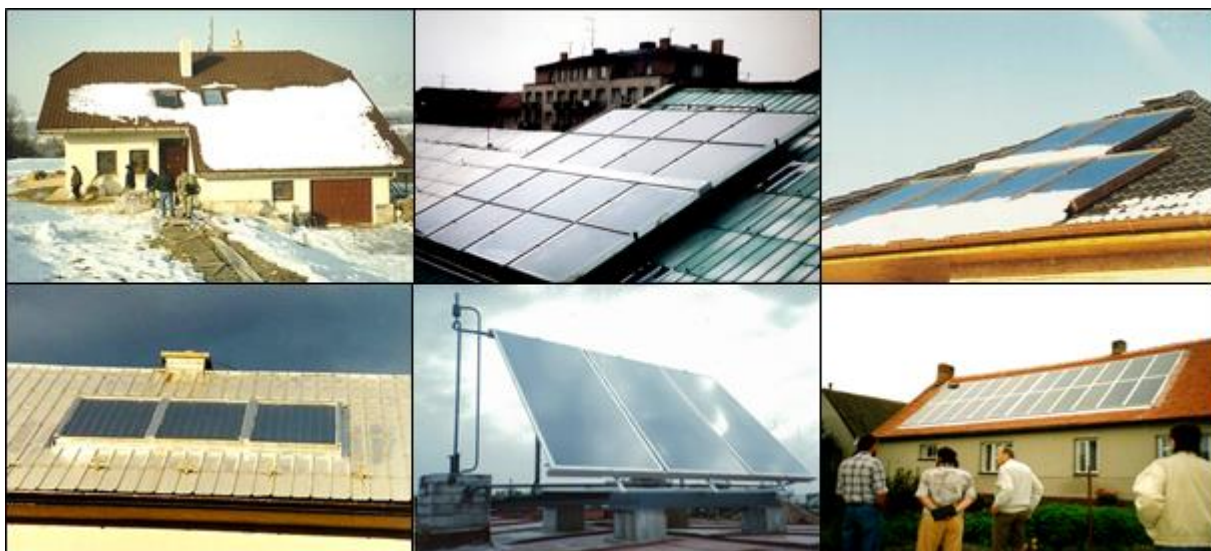
Obr. 4 Umístění kolektorů na střeše.
