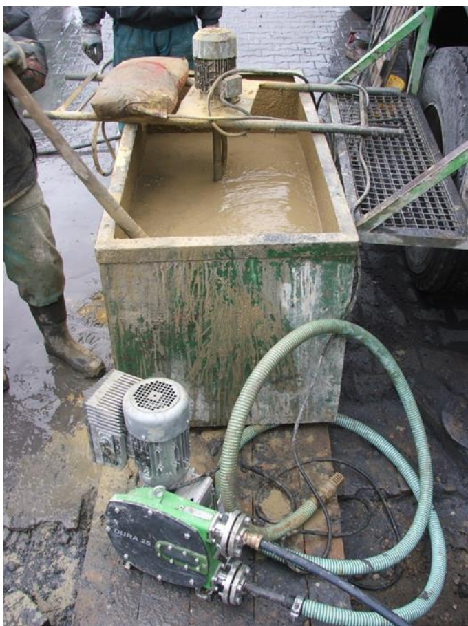
Obr. 6 Kontrola injektáže vrtů pro tepelná čerpadla, měření tepelných odporů vrtů (zdroj: Stavební geologie - Geosan s.r.o.)
