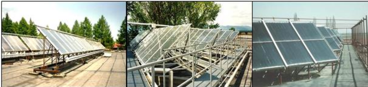
Obr. 9 Ochrana strešního pláště.
